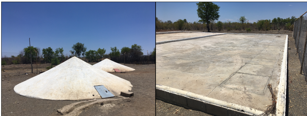
Componentes da cisterna-calçadão, Tunda Um (Chiange).
